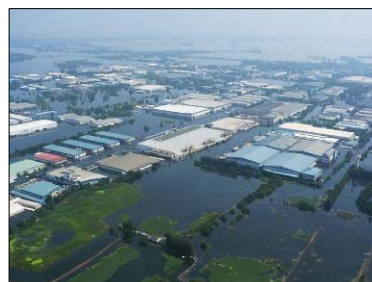
浸水した工業団地
